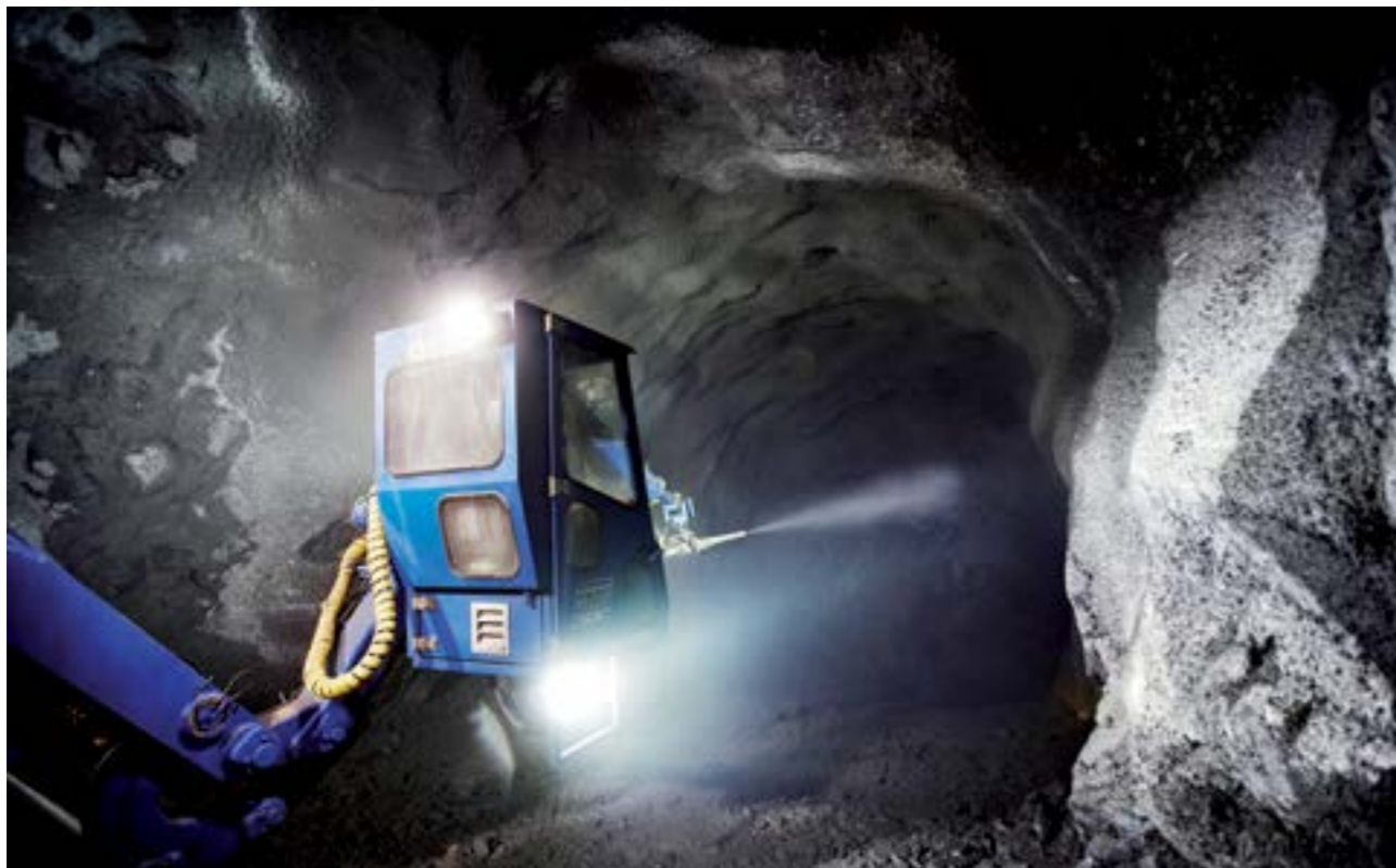
Förstärkning genom betongsprutning inom LKAB. (Arkivbild)
