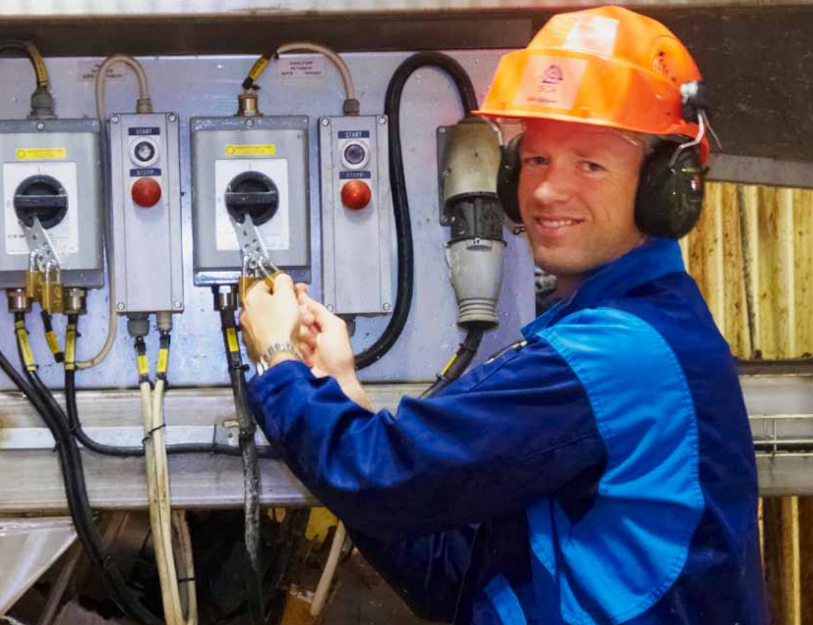
De vanliga brytarlåsen är ett enkelt exempel på hur säkerhetsarbetet ska fungera i vardagslag. Erik Sjöblom på SCA Östrand visar. (Foto Per-Anders Sjöqvist)
